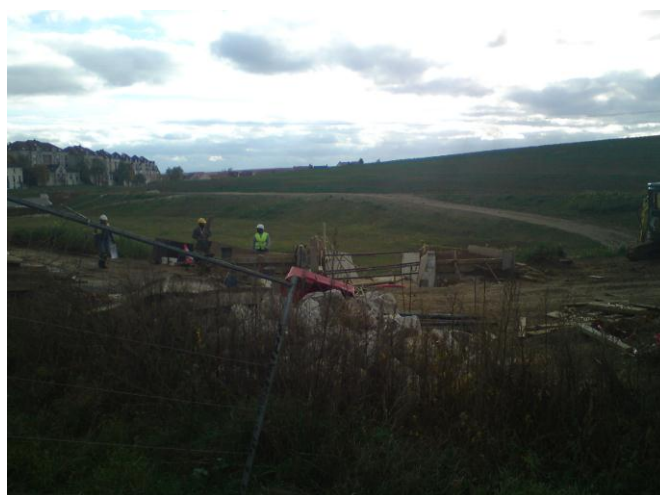
Figure 35 : Bassin de rétention en cours de création – le 04-11-2010
