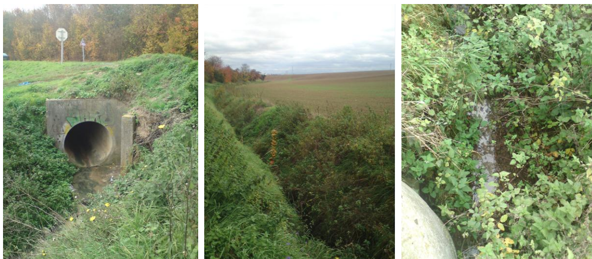
Figure 34 : Fossé à l'est de la zone d'aménagement – le 04-11-2010
